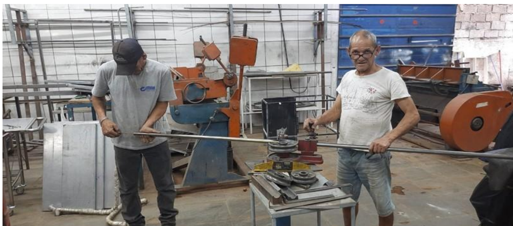
Figura 11: Viradeira de Tubos – Produção de Componentes da Estrutura
